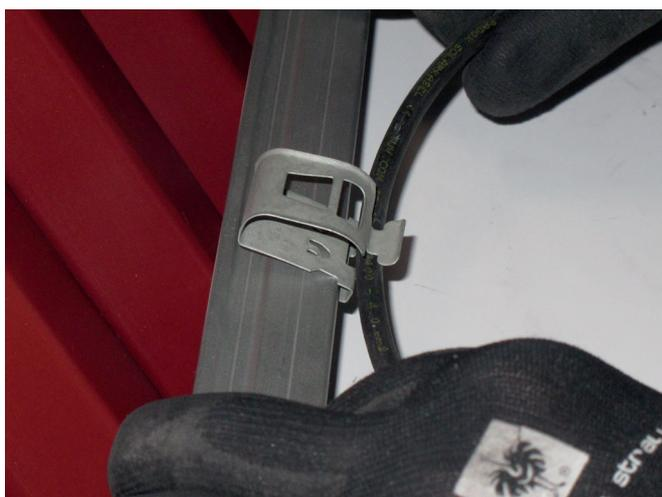
Vor der Modulfixierung, die Modulkabel in den Cable Routing Clip einhängen.
