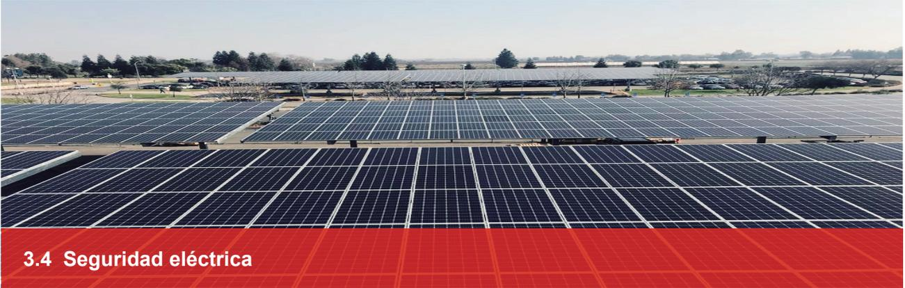
Los productos fotovoltaicos generarán corriente continua bajo condiciones de luz, por lo tanto, tome las medidas de protección adecuadas (guantes aislantes, zapatos aislantes, etc.) para evitar el contacto directo con personas con voltajes de corriente continua de 30V o más. El voltaje de CC de 30 V o más es potencialmente mortal.
