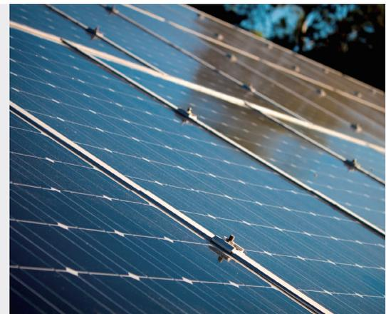
Cuando el módulo está funcionando, está estrictamente prohibido cubrir algunos o todos los factores ambientales del módulo, como otros módulos, soportes del sistema del módulo, estancias para pájaros, mucho polvo, tierra o plantas, etc., lo que causará una reducción significativa en la potencia de salida. LONGi Solar recomienda que la superficie del
