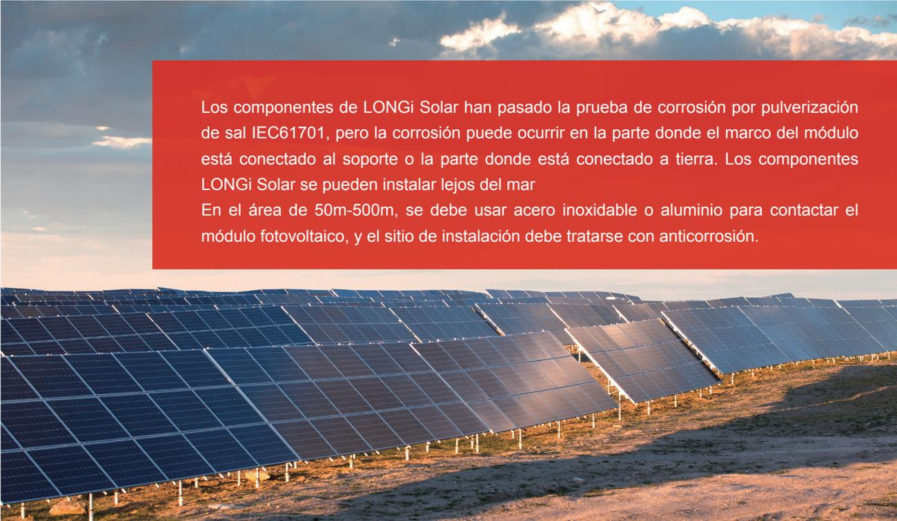
Los componentes de LONGi Solar han pasado la prueba de corrosión por pulverización de sal IEC61701, pero la corrosión puede ocurrir en la parte donde el marco del módulo está conectado al soporte o la parte donde está conectado a tierra. Los componentes LONGi Solar se pueden instalar lejos del mar
